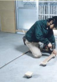
床スラブに接着固定したアジャスターボルトのレバーを取付けます。
