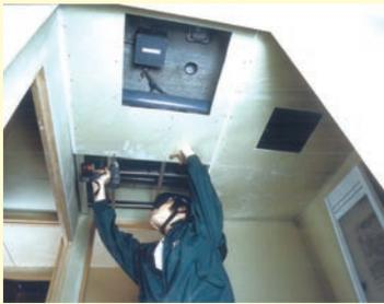
天井下地に天井パネルや石膏ボードを貼り施工します。
