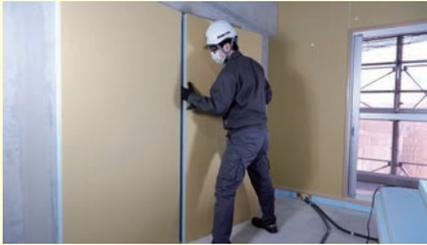
躯体に断熱複合板を専用接着剤を使用して貼付けます。(S1工法)
