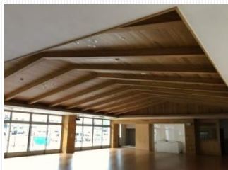
佐用朝霧養護老人ホーム (天井、壁羽目板、垂木に不燃木材使用)
