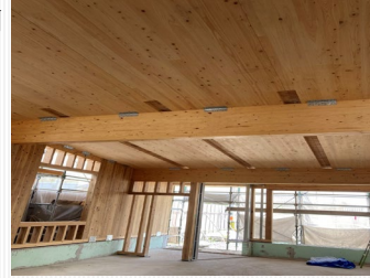
CLT屋根施工
