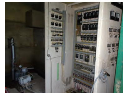
給水ポンプ用ブレーカーの復旧（鯨岡団地）
