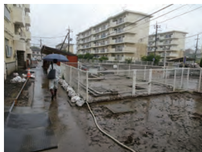
浄化槽の浸水状況（叶田団地）
