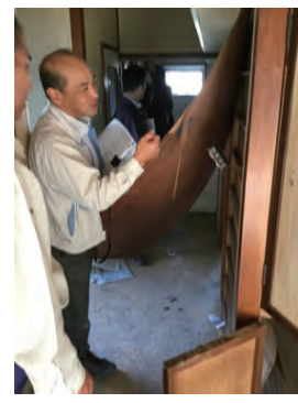
11月8日 鯨岡団地現場調査状況
